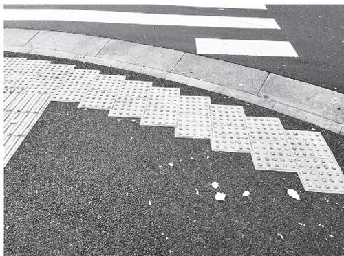
図9 方形点字ブロックの歩道巻込部の屈折配列
