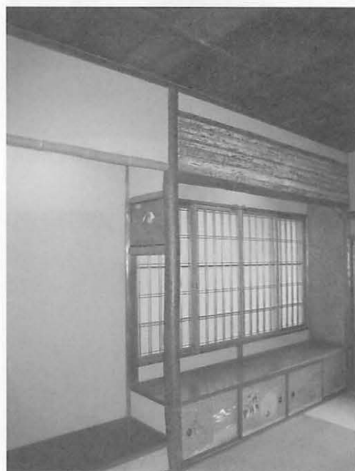
図13 三井邸 望海床 竿縁天井、土壁の数寄屋風デザイン
