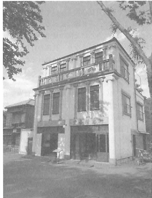
図10 村上精華堂 全面がモルタル塗で、防火対策（延焼防止）とられている
