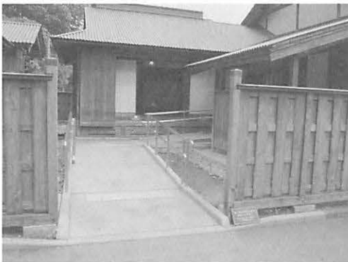
図8 万徳旅館のスロープ スロープの始りに黄色い注意喚起ブロックが設置されている
