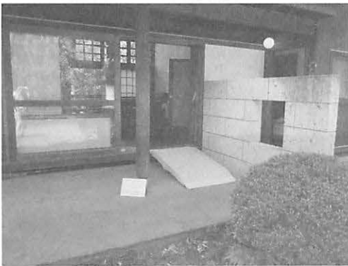
図7 前川國男邸のスロープ 中央に縞鋼板の簡易なスロープ
