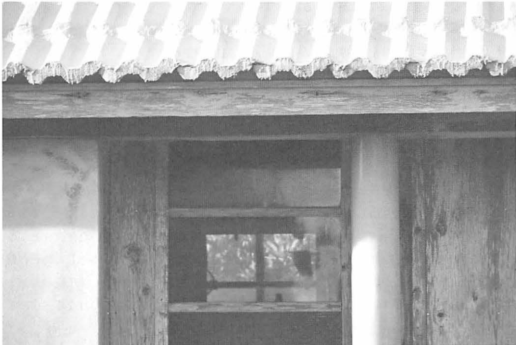
図6.8 塩ビ管とコンクリートで造られた雨端柱
