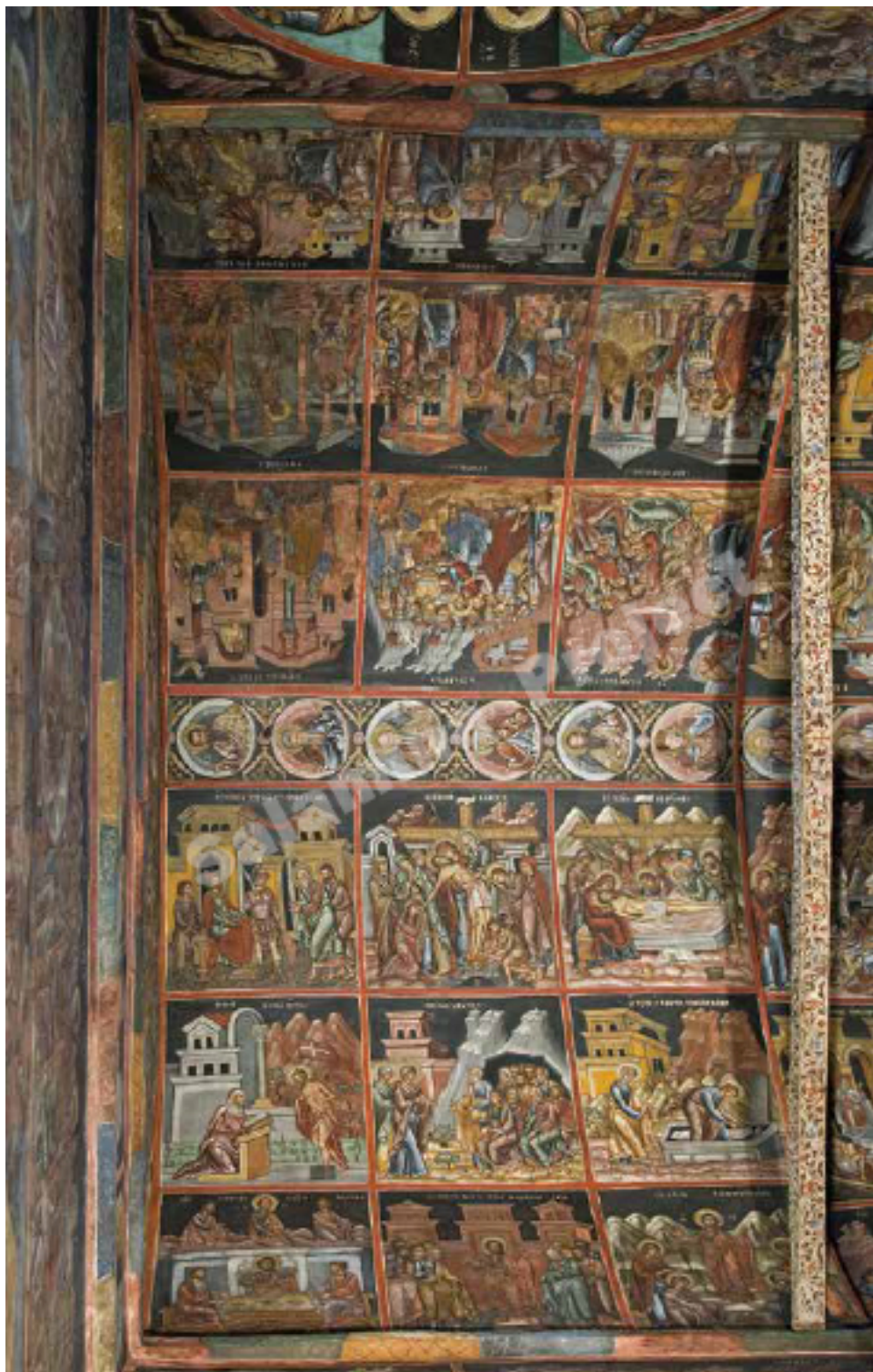
図 31 身廊の第 3 穹窿天井 P. ファネロメニ修道院
